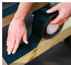
Bescherm de onderbalk met Bitudeck (Art.2306) zie Cobrafastener catalogus.
